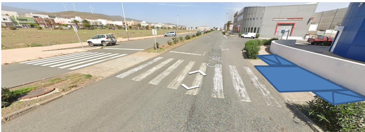
Imagen 05.4. Cruce de calzada con mediana en calle del Telar.
